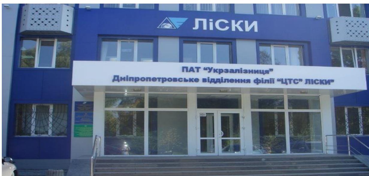
Рисунок 2.1 – Зовнішній вигляд головної будівлі митного поста «Ліски» Дніпровської митниці [13]
