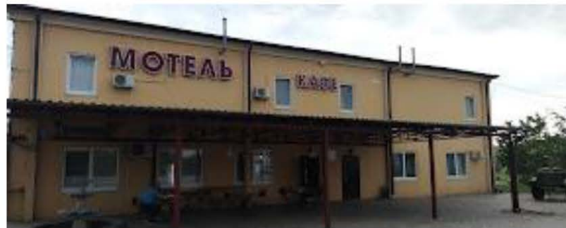
Рисунок А.1 – Зовнішній фасад мотелю «Привал» [6]
