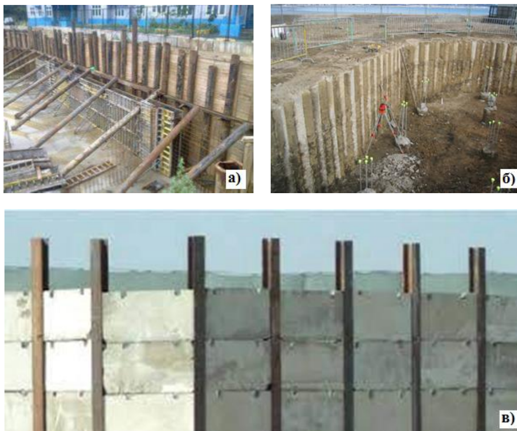
Рис. 2. Типи шпунтових огорожень: а) – з дерев'яним щитовим заповненням; б) – з залізобетонним заповненням між палевого простору; в) – з жорстким вертикальним армуванням.
