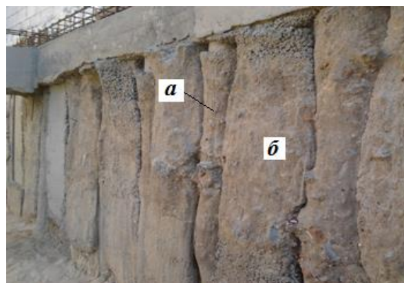
Рис. 5. Результати впровадження пропонованої технології. а – свердловина; б – між палевий простір заповнений бетоном
