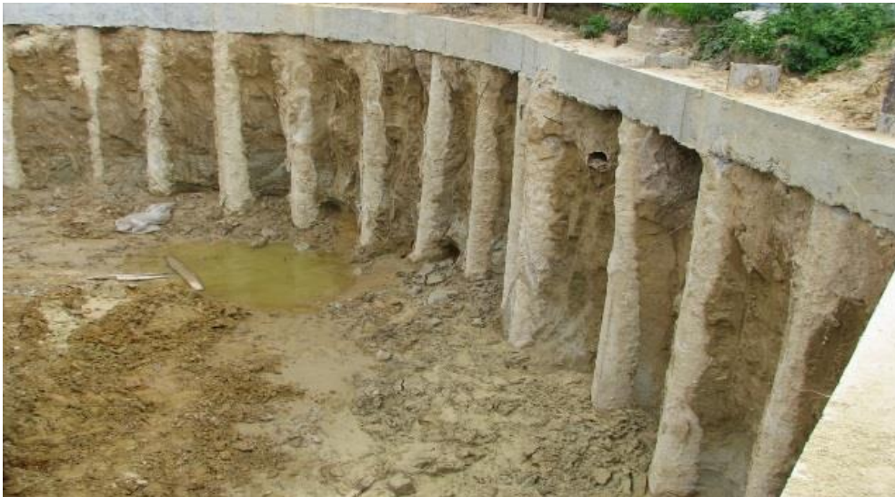
Рис. 1. Шпунтове огородження з незаповненим між палевим простором.
